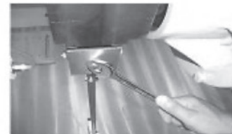
斜めに差し込んでいる
