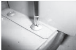
差し込みが不十分 径があっていない
